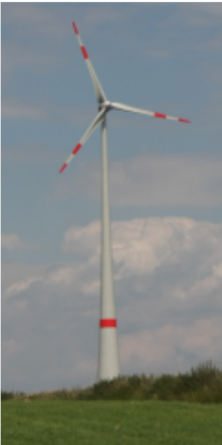
Eines von vielen Windkraftträgern im Main-Kinzig-Kreis.
