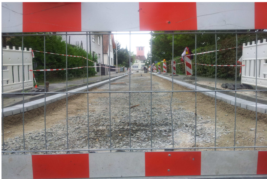
Beispiel einer grundhaften Erneuerung
